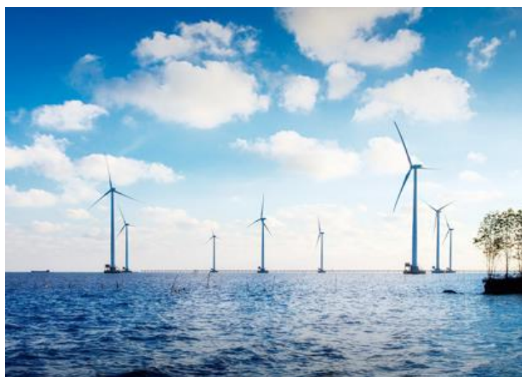
Figure 1.20: Offshore 99.2 MW Bac Lieu wind farm, Viet Nam
