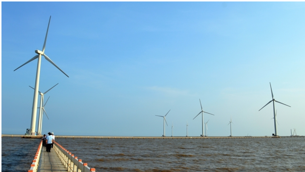
Wind Turbines at Bac Lieu Wind Farm
