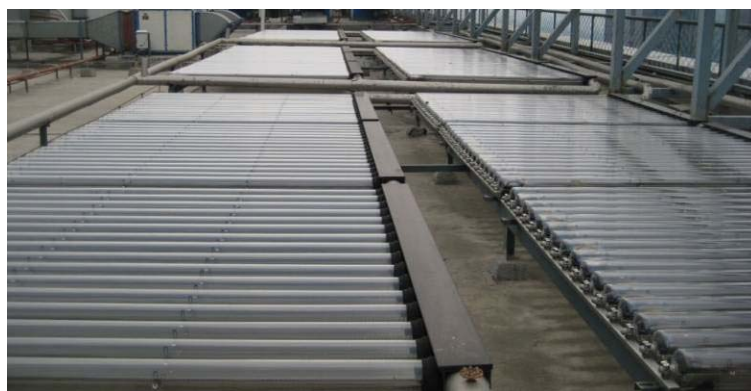
Fig. 4-3 Solar thermal collector
