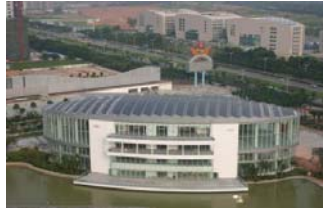
深圳国际园林花卉博览园1兆瓦并网光伏电站
