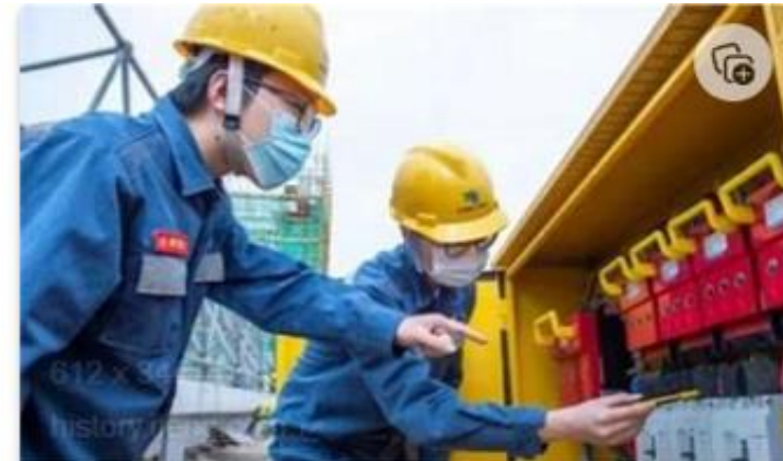
全国多地政府拉闸限电，这种降低能耗的管控措施是否可取？_凤凰网视频_凤凰网
